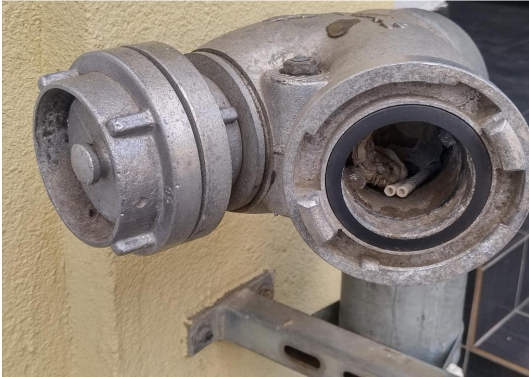
2. melléklet: Egy másik zuglói társasház száraz felszálló vezetékének utcai tápláló ága. A Storz-kupak már eltűnt, a közeli buszmegálló várakozói, pedig szemetesként használták. Forrás: Hózer Benjámín felvétele.
