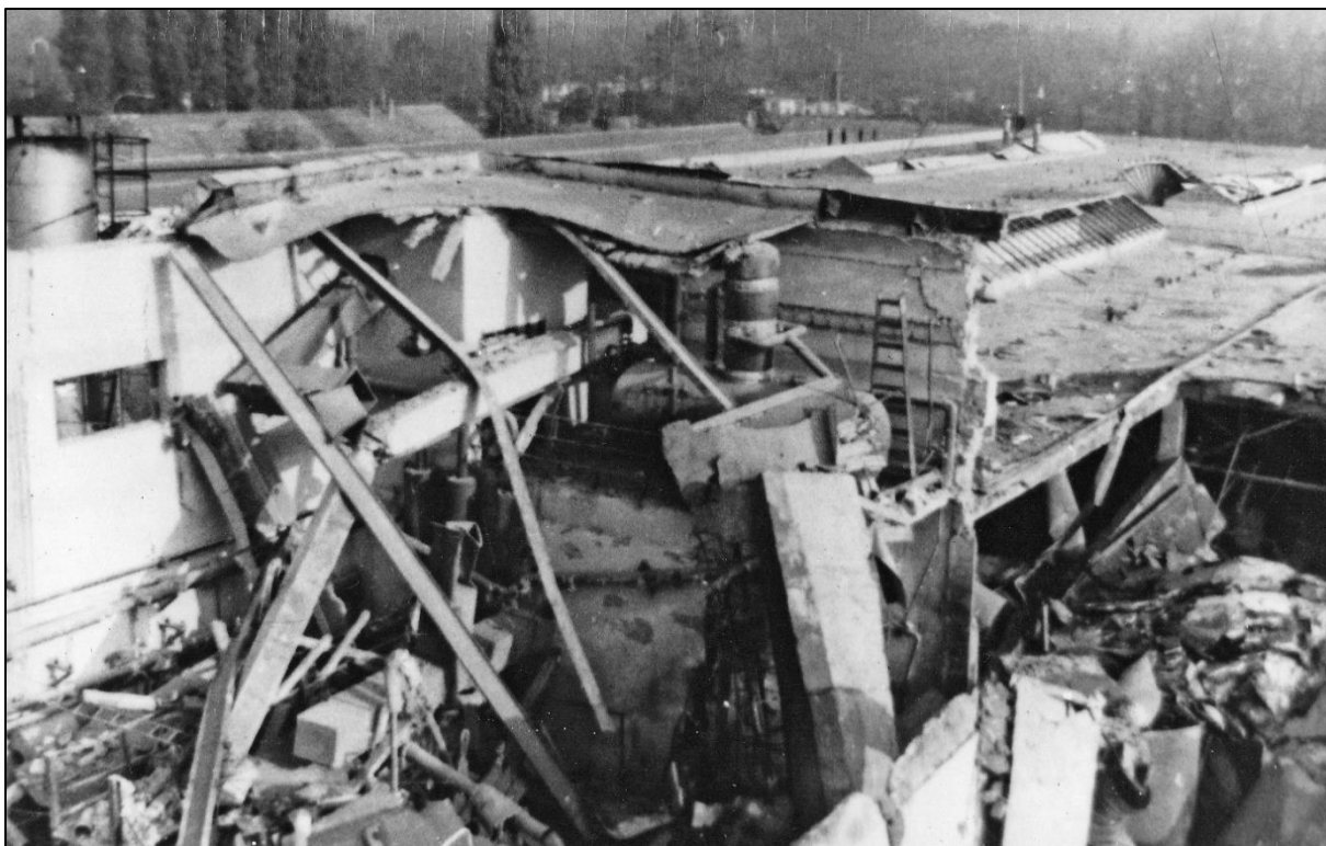
8. kép: A leomlott födém magaspontról szemlélve. Háttérben a Vörösmarty MgTSz Forrás: Hózer Benjámín gyűjteménye
