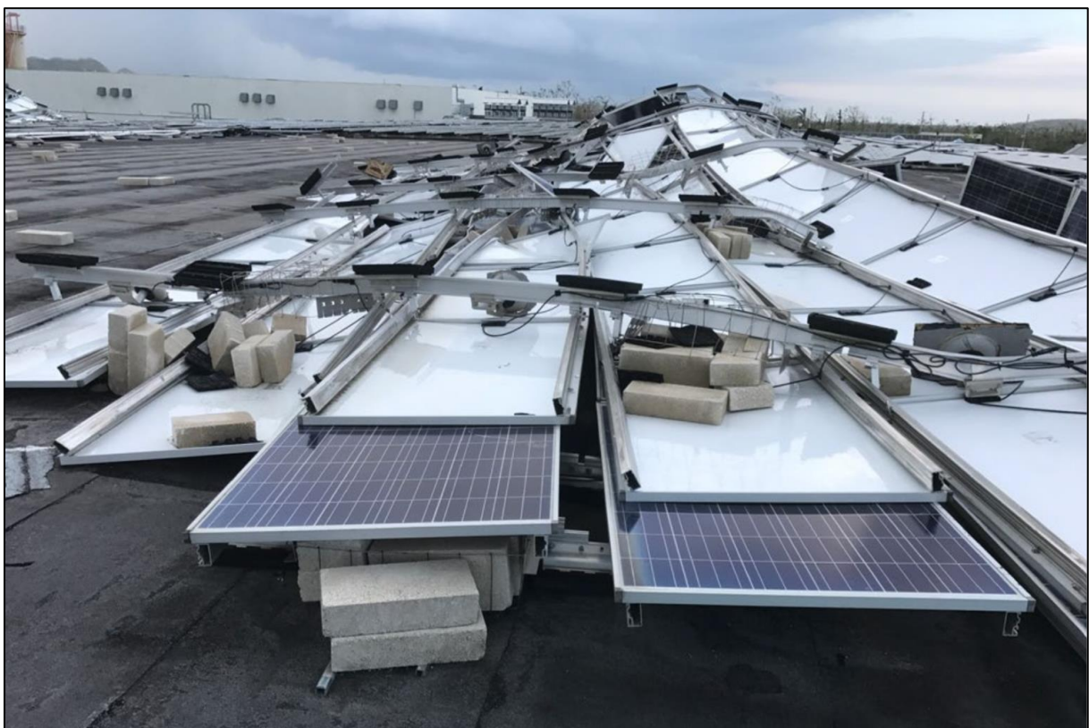
8. kép Viharkár egy lapos tetőre telepített rendszerénél (Forrás: ld. [6]).
