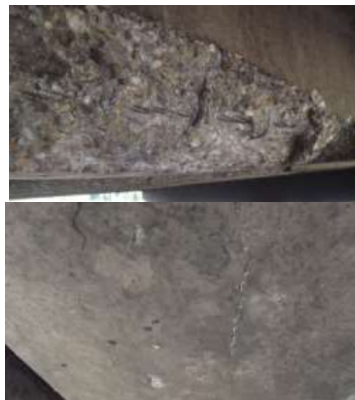
8. ábra: A hídgerendák károsodása és mintavétel (2017.06.01)
