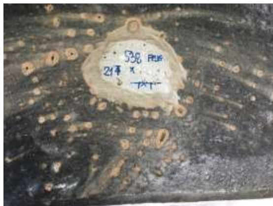
7. ábra: Felpikkelyesedett B-4 sóvédelmi bevonat és az alatta lévő csiszolt betonfelület (2017.06.01)
