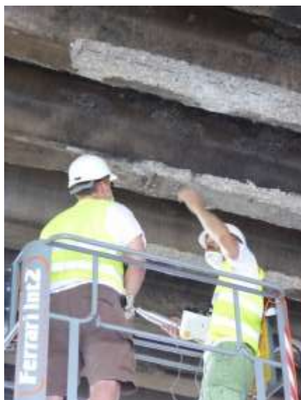
8. ábra: A hídgerendák károsodása és mintavétel (2017.06.01)
