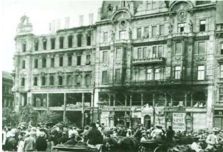
7. ábra – Parisi Nagy Áruház épület tűzvész utáni állapota
