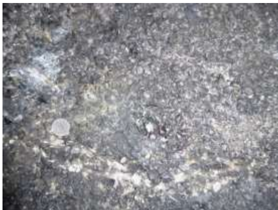
7. ábra: Felpikkelyesedett B-4 sóvédelmi bevonat és az alatta lévő csiszolt betonfelület (2017.06.01)
