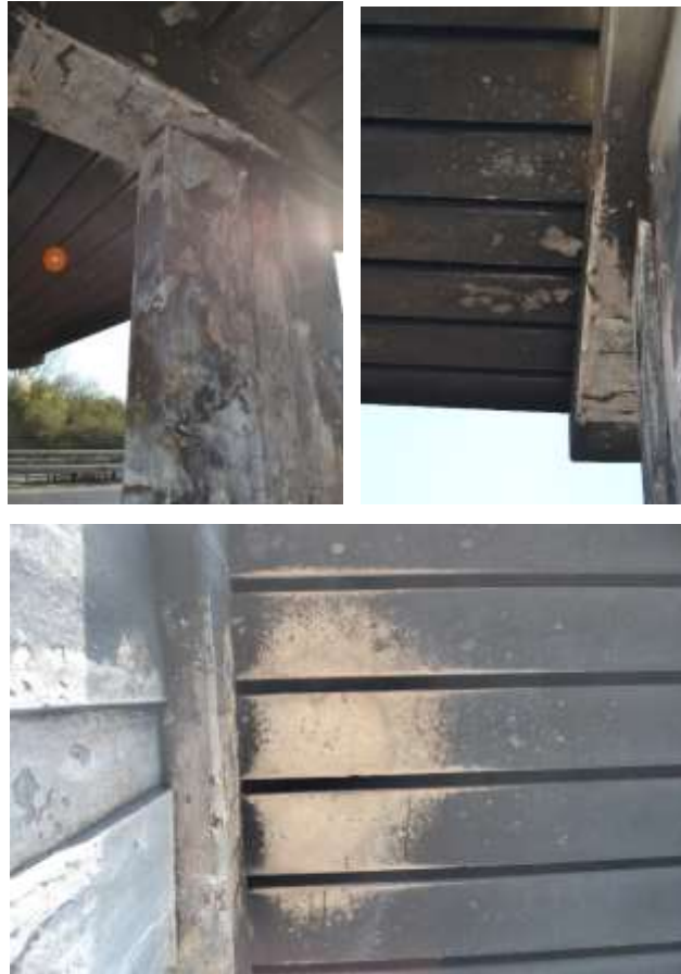
4. ábra: A fejerenda és a főtatók a tűzhatás után (2017. 03.31)
