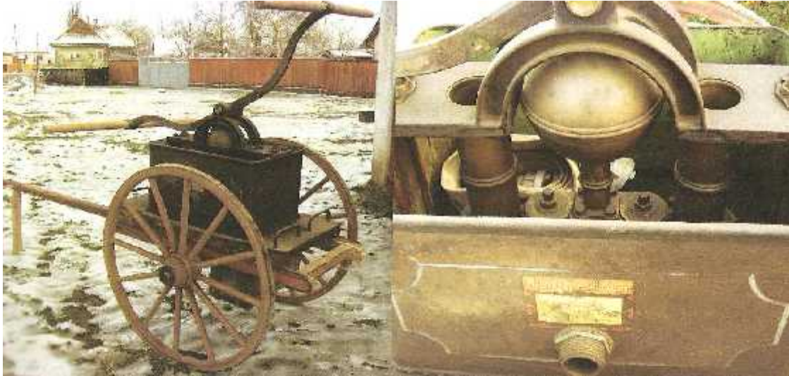
11. kép. Kétkerek Walser-féle targoncafecskend (Egerpatak)
