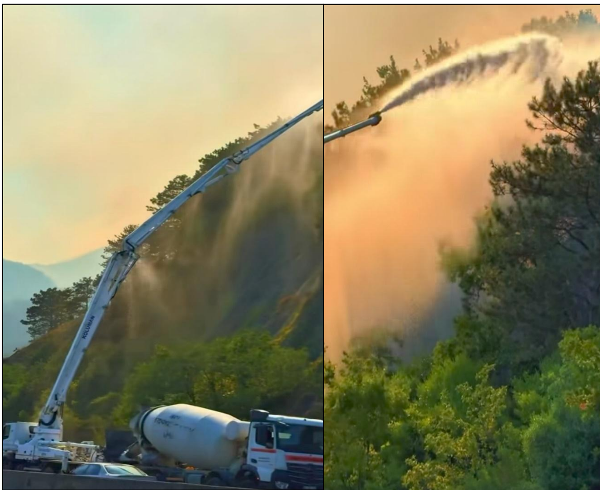
12. kép: Kiváló logisztika, betonpumpa és mixer. (Forrás: [9])
