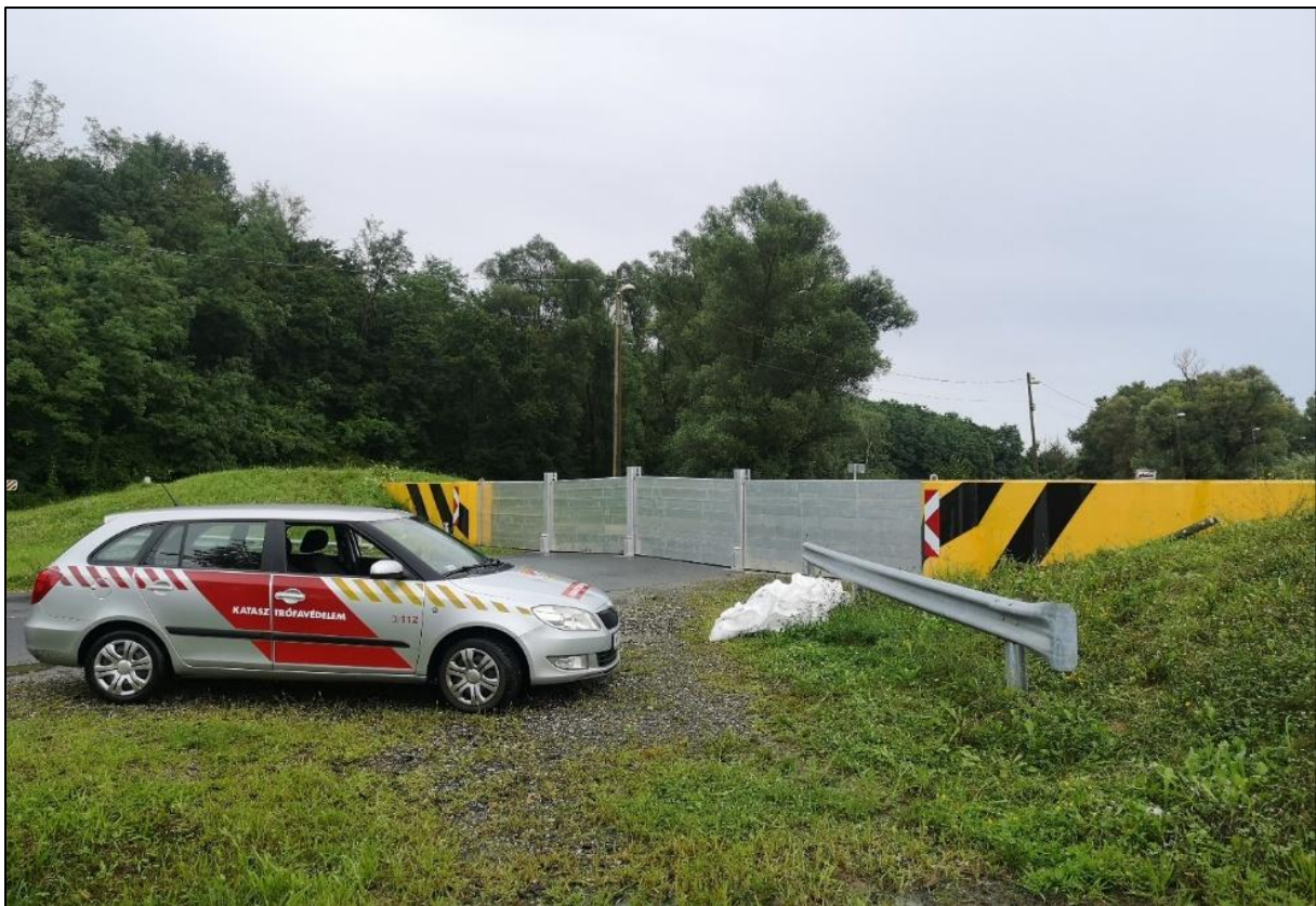
5. sz. kép: Murarátka 7538-as út Mobil árvízvédelmi fal (készítette Prepok Attila tű. alezredes)
