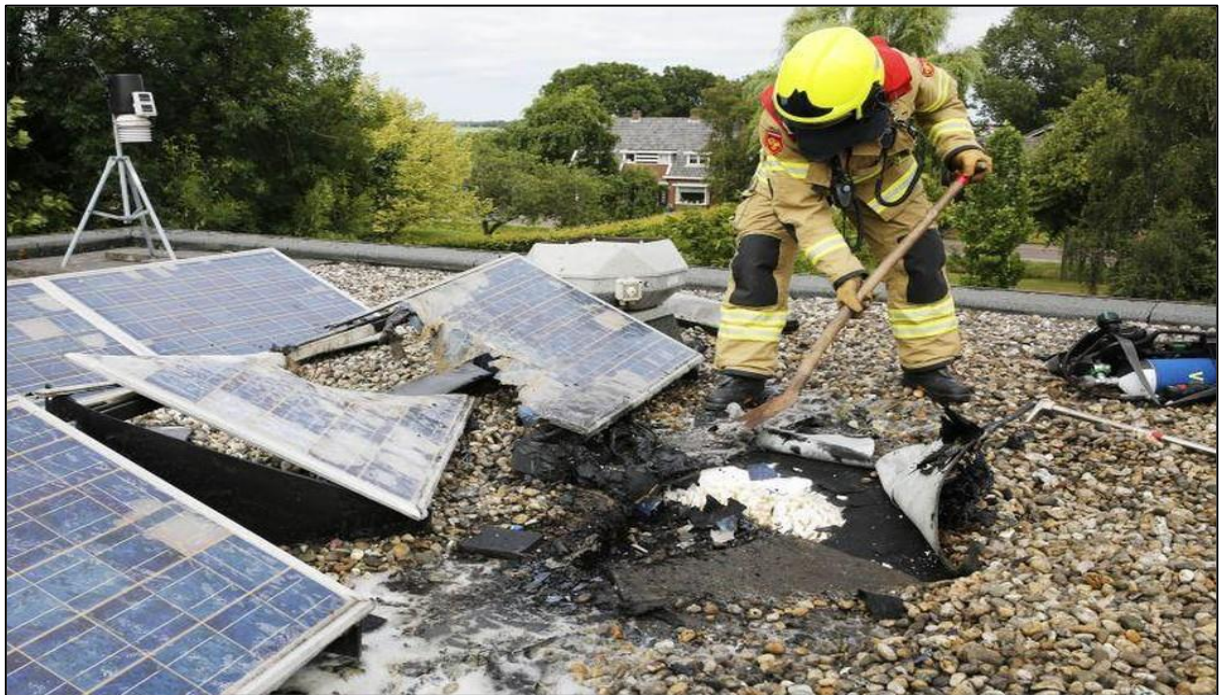
5. kép Beizzott szigetelés utómunkálatai egy lapos tetőn (Forrás: ld. [3])
