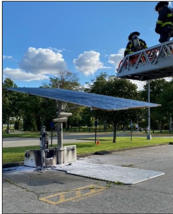
6. kép Elektromos autó kihelyezett töltőjének oltása PVSTOP eszközzel (USA) (Forrás: ld. [4])
