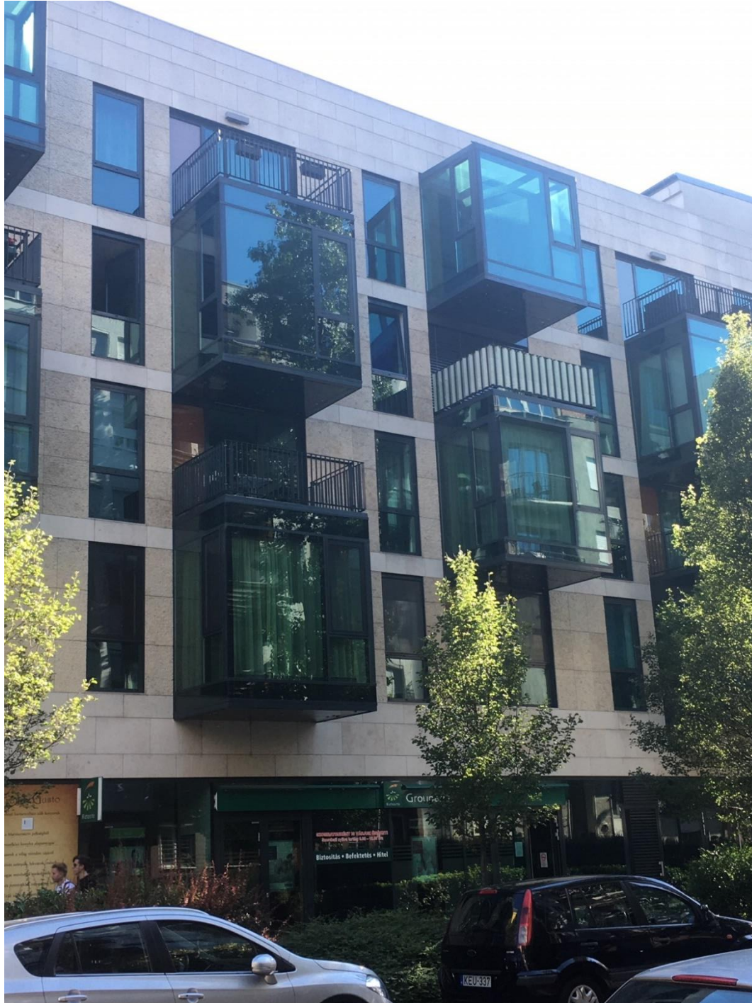
1. ábra: Síkban megmozgatott homlokzat, nem éghető burkolatokkal, (fotó: Oláh Krisztián, Budapest 2020 július)
