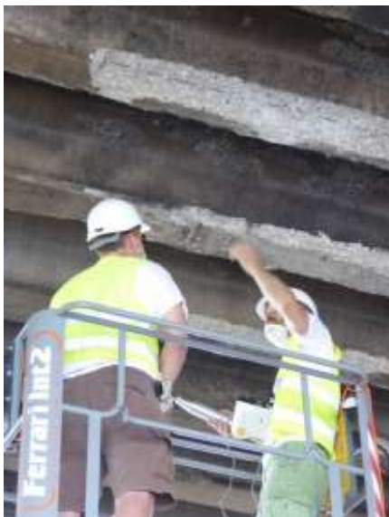
8. ábra: A hídgerendák károsodása és mintavétel (2017.06.01)
