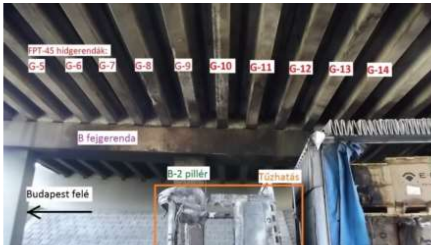
6. ábra: Tűzzel érintett szerkezeti elemek jelölése, B támasz Mohács felőli nézete (2017.06.01.)
