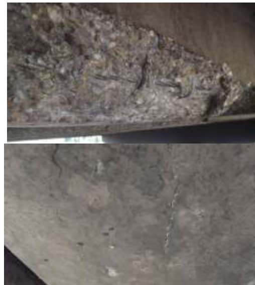
8. ábra: A hídgerendák károsodása és mintavétel (2017.06.01)
