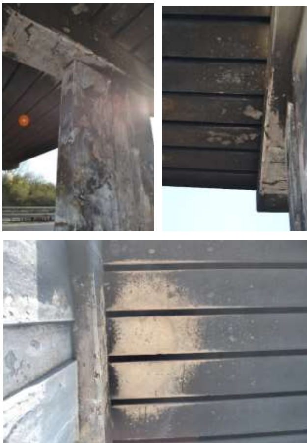
4. ábra: A fejtárcsa és a főtartók a tűzhatás után (2017. 03.31)
