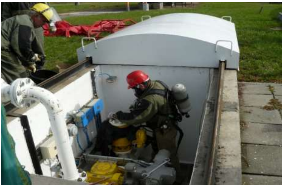
3. fénykép: Az alvállalkozó által végrehajtott vezeték leürítés.
