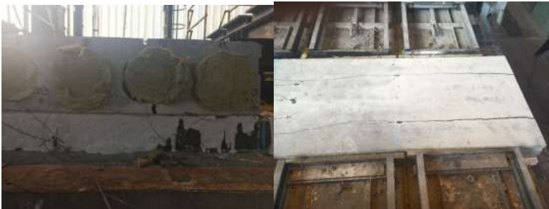
1. ábra: Hosszanti repedések a körüreges földémpallón 3 perc hőterhelést követően
