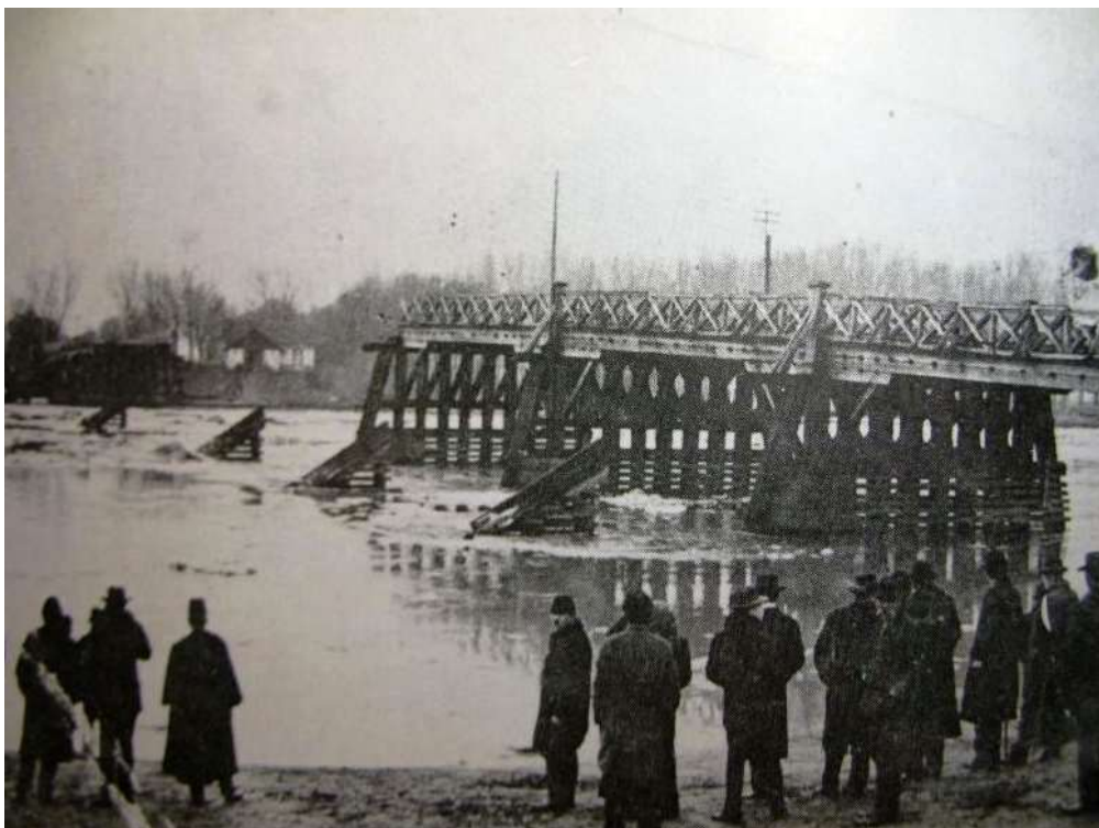
4. ábra: A jeges árvíz rombolása – A szolnoki közúti híd maradványai 1909-ben
