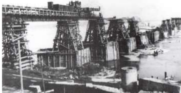
13. ábra: Az épülő szegedi cölöpjármos vasúti híd 1944. telén 23
