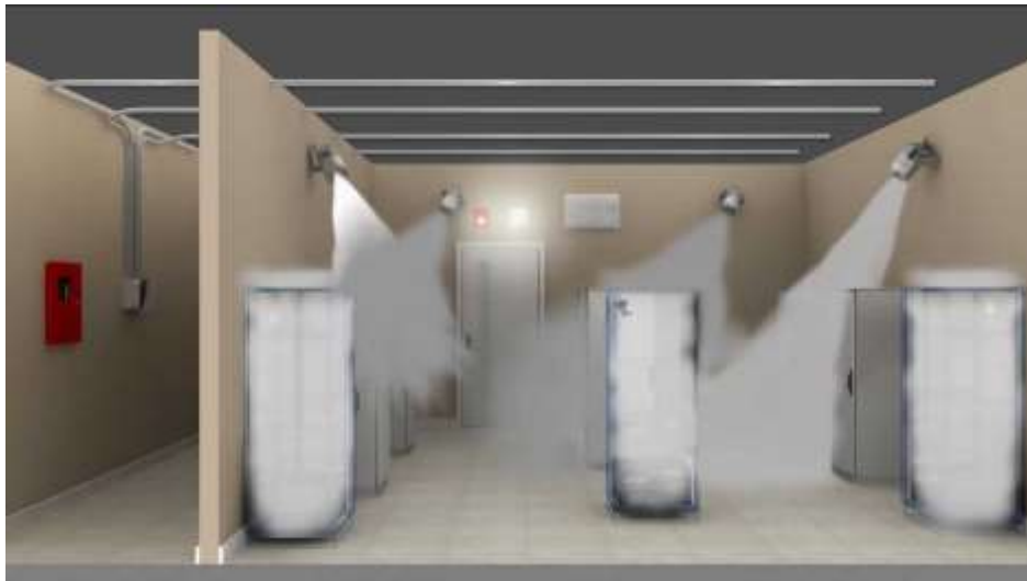
7. ábra: Aero-K által fejlesztett gázzal oltó [16]
