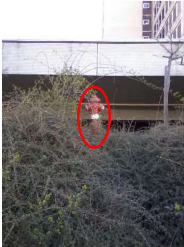
3. kép Tűzcsaphoz vezető út növényzettel sűrűn borított [15]
