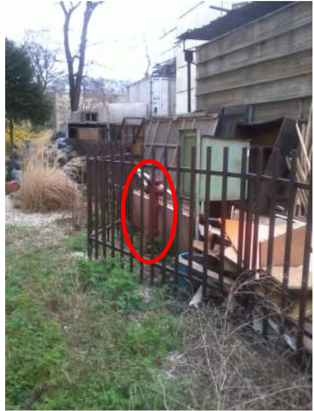
2. kép Tűzcsap kerítés és tárolt anyagok között [15]
