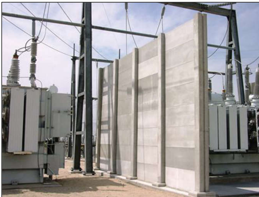
6. ábra: Transzformátor tűzfal [15]
