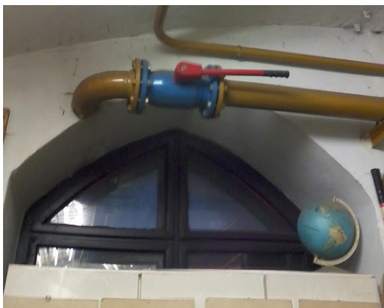
3. kép: A fogantyú magassági helyzete (2,9 m) nehezíti az elzárást (forrás: szerző saját felvétele)
