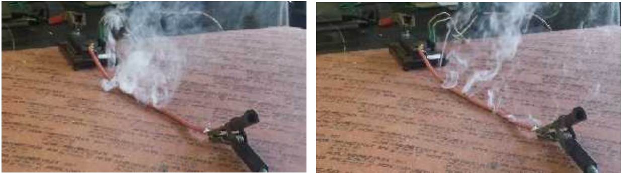
2. ábra: Viselkedés: 40 amper és 188 °C -nál füstölni kezdett a szigetelés. Forrás: szerzők
