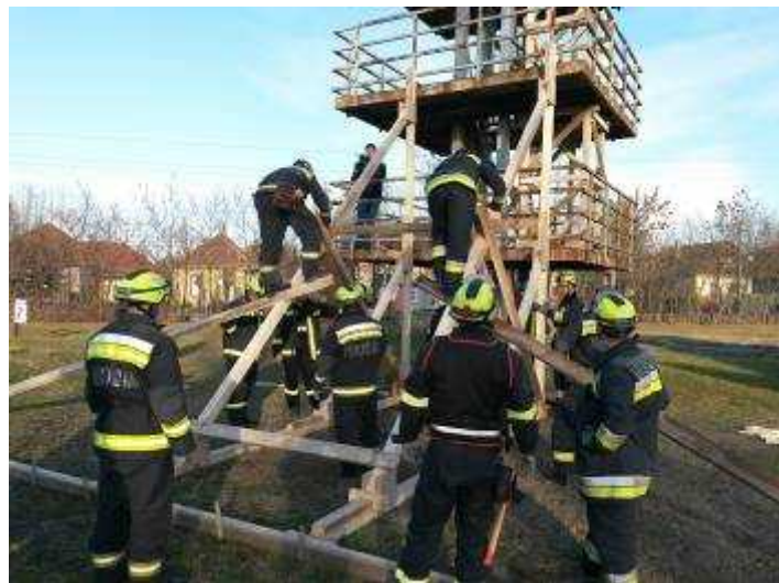
9. ábra: „Romosodott épület” megtámasztását gyakorolja a HUNOR állománya az Egyesült Királyság Nemzetközi Kutató és Mentőcsapatának szakértőivel, Keith Bellamy és James Delaney tisztelettel, a BM OKF Gazdasági Ellátó Központ Ferihegyi úti Kiképzési és Raktárbázisán, 2015. november 17-25. között. Készülés a londoni gyakorlatra és az INSARAG második újraindításra. Fotó: UK ISAR
