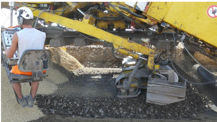
6. ábra. A PM 1000 URM kiegészítő réteg beépítése közben
