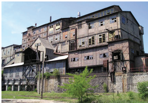
27. ábra: A szénosztályozó és mosó épülete a Liász-program keretében végrehajtott, 1989-es átépítés után. (Pécsújhegy. Fotó: Uherkovich Péter, 1999.)
