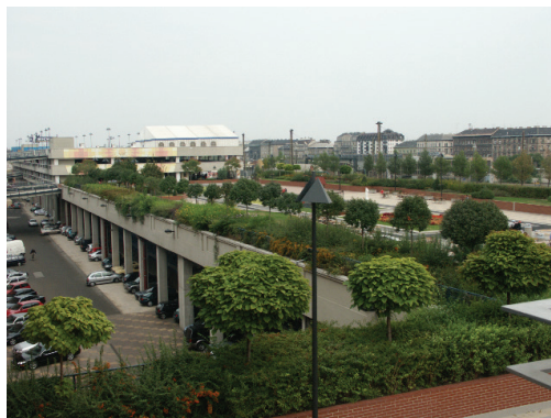
2. sz. ábra: Nyugati pu. felülepített vágányok, tetőterasz és parkoló a vágányok fölött (forrás: saját)
