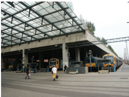
2. sz. ábra: Nyugati pu. felülepített vágányok, tetőterasz és parkoló a vágányok fölött (forrás: saját)
