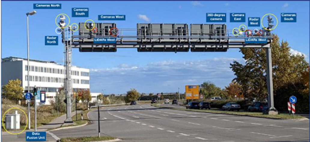
1. ábra: A Providentia++ projektben [2] alkalmazott tartószerkezet és a rá telepített infrastruktúra szenzorok
