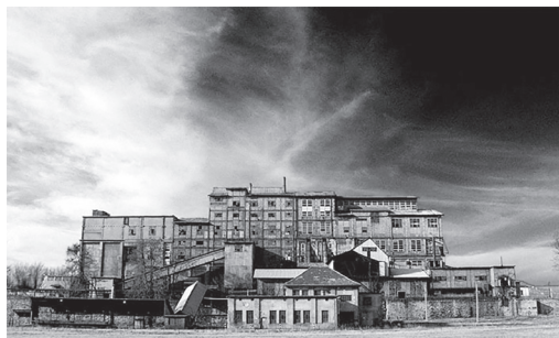
11. ábra: A szénosztályozó és mosó épülete (1914-2009) az átalakításokat követően.
