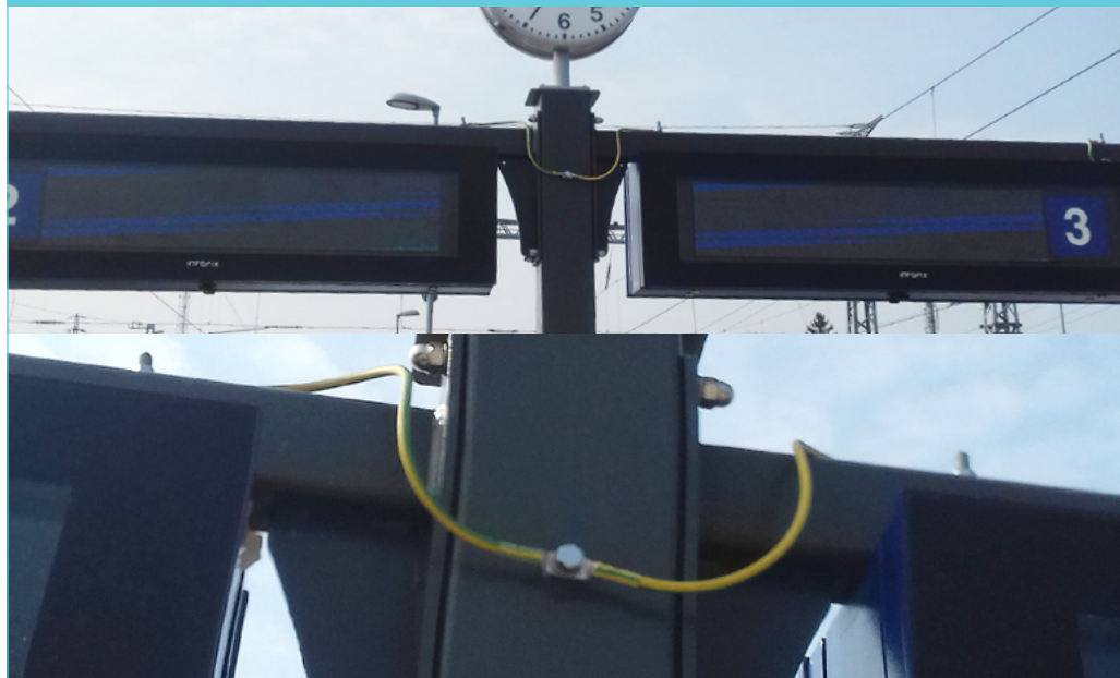
1. ábra: Felületes földelések Pécel állomás peronkijelzőjén
