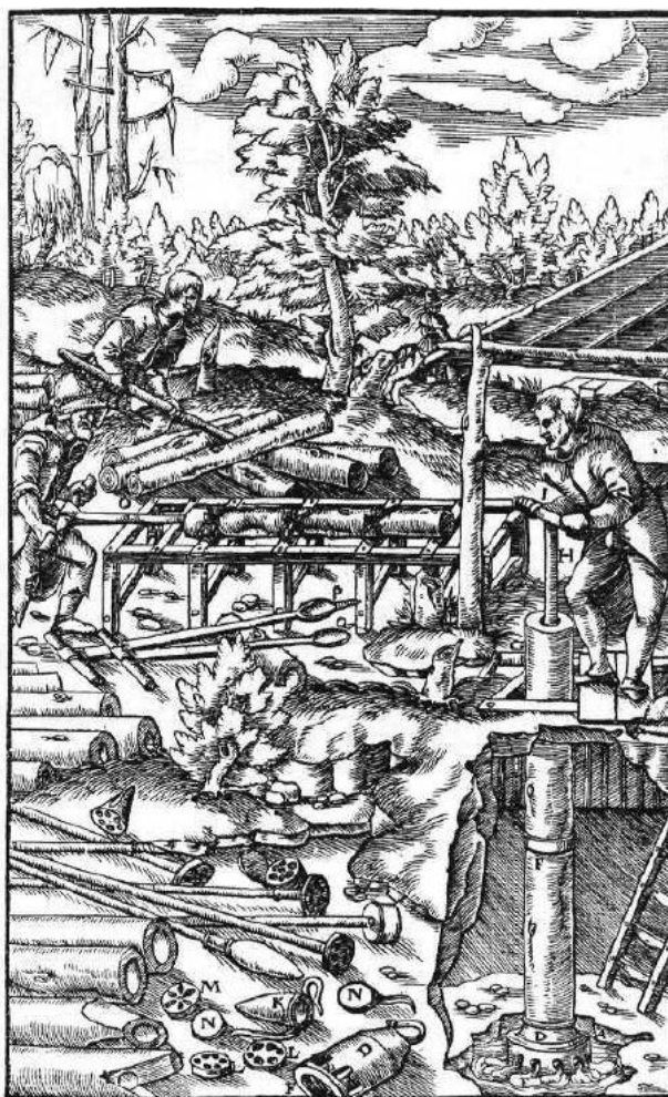
4. ábra. Facső kifűrésa és fűrészszerszámok rajza, O - munkás aki facsövet fűr, P – csavarfűró, Q – kanalas fűró (Agricola 1556) Figure 4. Drawing of drilling a wooden pipe and drilling tools, O – worker drilling a wooden pipe, P – screw drill, Q – bucket drill (Agricola 1556)
