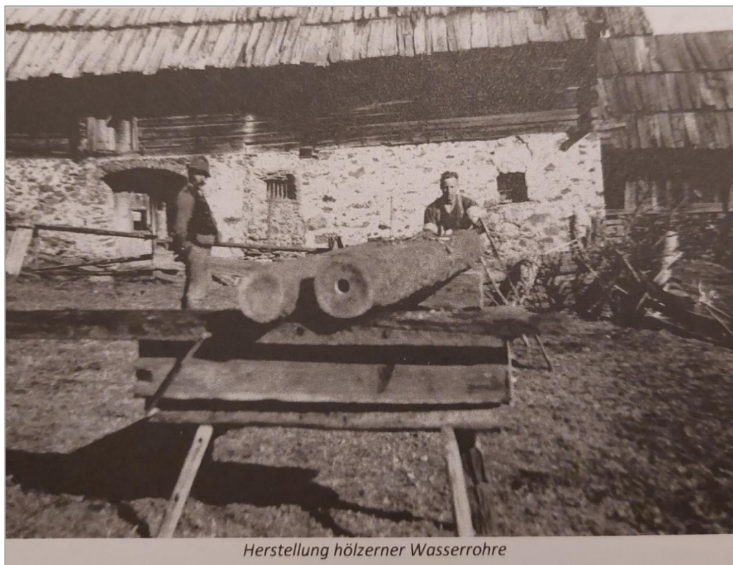
12. fotó. Fa vízvezetékek készítése (Wieland 2023) Photo 12. Making a wooden water pipe (Wieland 2023)
