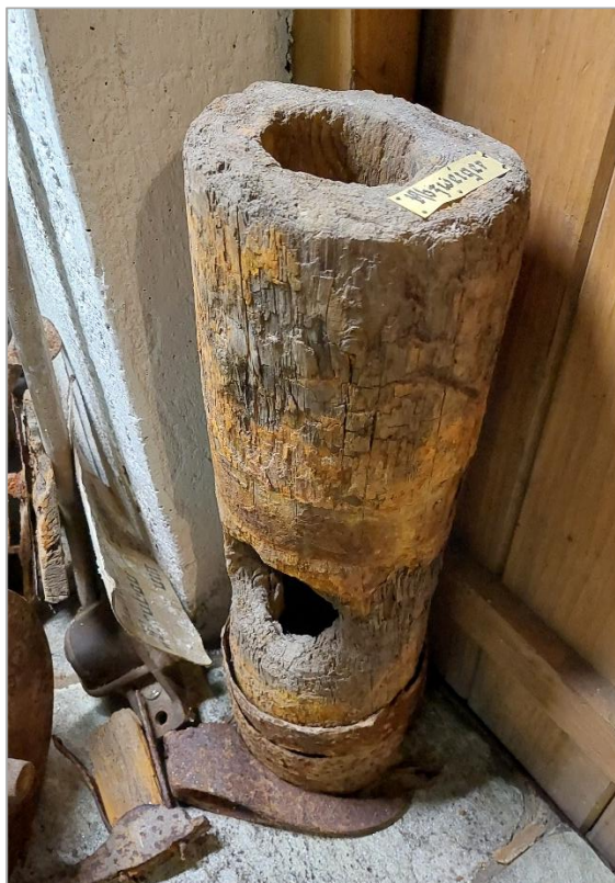
11. fotó. Bányából származó fa vízcső töredék az ausztriai Rauris település helytörténeti múzeumában (szerző felvétele: 2022. 08. 19-én) Photo 11. Fragment of a wooden water pipe from a mine in the local history museum of at Austrian town of Rauris (author's photo in 2022. 08. 19.)
