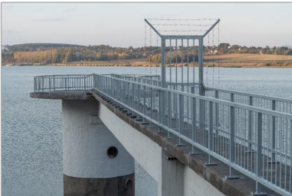
5. kép. A Fehérvárcsurgói-tározó fenékleürítő műtárgya (Fotó: KDTVIZIG)
