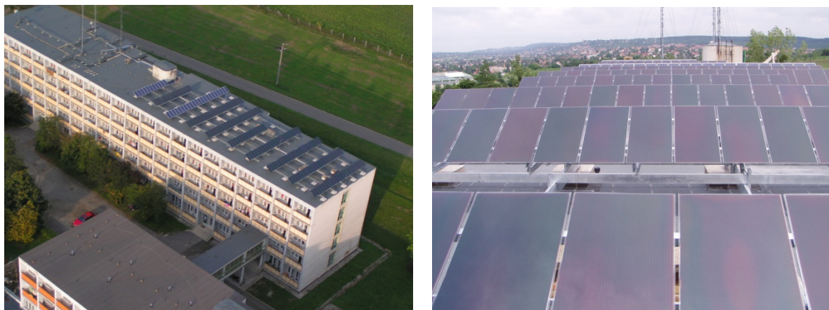
4. ábra: Szent István Egyetem 10 kW névleges teljesítményű naperőműve
