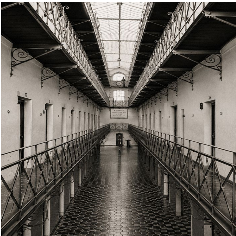
3. kép: Belső kép a börtönfolyosóról és a zárkákról 4
