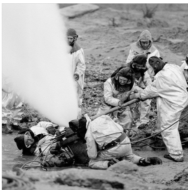
12. kép. A bélésűcsőfej előkészítése
