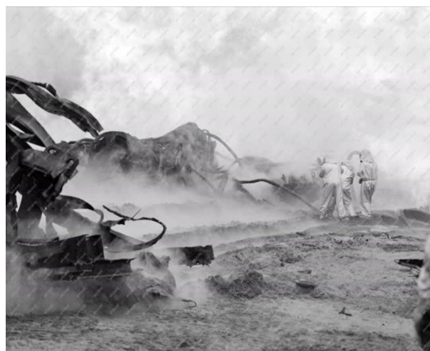
7. kép. Fűróberendezés roncsainak eltávolítása
